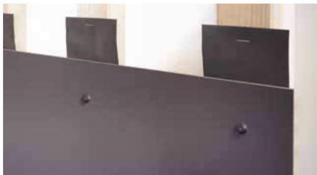
Dřevěná podkladní konstrukce - šroubování
