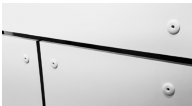
Kovová podkladní konstrukce - nýtování
