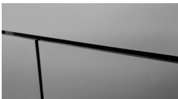
Kovová podkladní konstrukce - lepení
