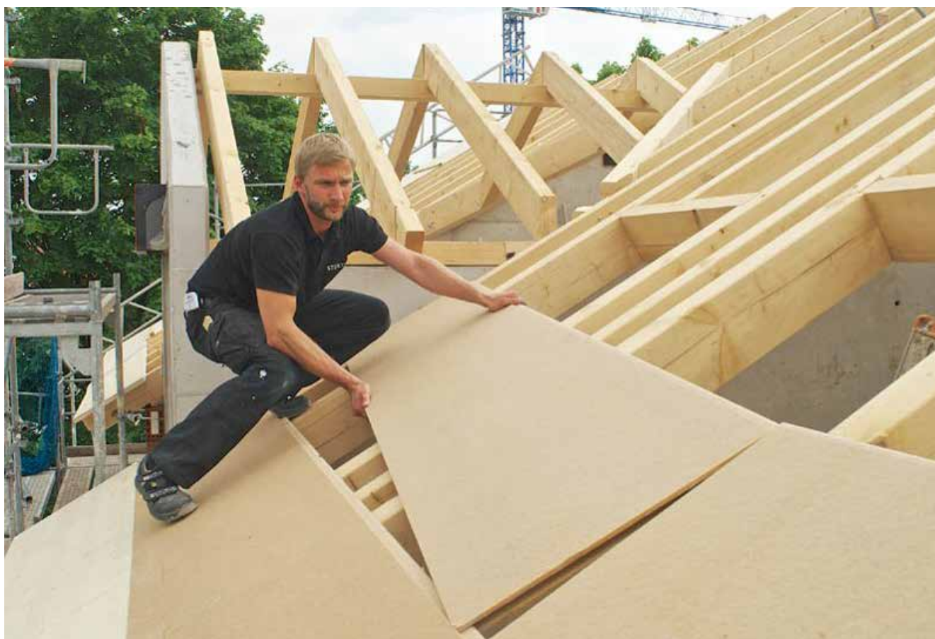
zateplení střechy pomocí nadkrokovovou deskou STEICO special dry
