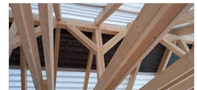
skutečnost na stavbě
